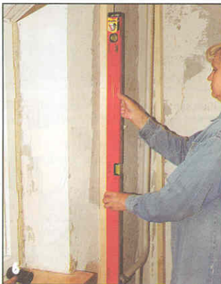
Вертикальность реек обрешетки контролировали по уровню. Небольшие отклонения в пределах чувствительности уровня (0,5-1,5 мм/1 м) устранили за счет эластичности прокладок. Большие — подстругиванием реек.
