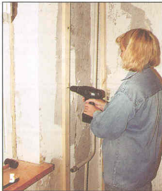
Вертикальность реек обрешетки контролировали по уровню. Небольшие отклонения в пределах чувствительности уровня (0,5-1,5 мм/1 м) устранили за счет эластичности прокладок. Большие — подстругиванием реек.
