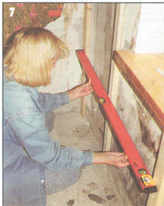
Вертикальность реек обрешетки контролировали по уровню. Небольшие отклонения в пределах чувствительности уровня (0,5-1,5 мм/1 м) устранили за счет эластичности прокладок. Большие — подстругиванием реек.
