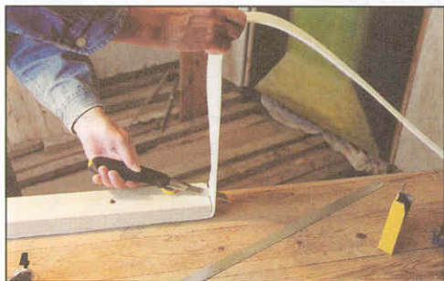
Раскраивать рулонный пенополиэтилен удобно портняжными ножницами, а резать потом полосы из него прочим универсальным ножом с выдвижным лезвием.
