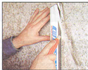
С помощью металлической шины и острого резака прорезают полосы обоев, наклеенные с напуском 2-3 см. Оба обрезка удаляют. Стык полос обоев — безупречен.
